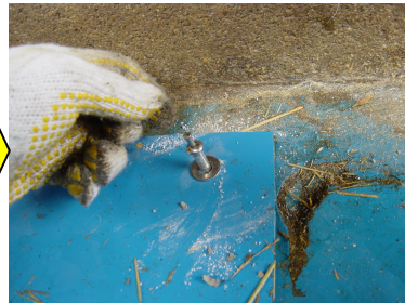
⑦ワッシャをかまして、アンカーボルトを差し込みます。
