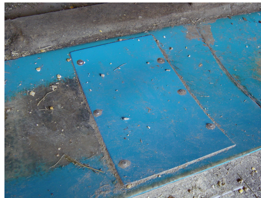
⑧アンカーボルトの頭を確認します。
