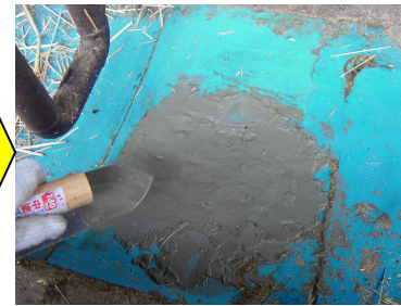
④モルタルで、穴を埋めます。
