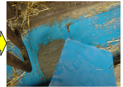
⑤FRP補修板を、置きます。
