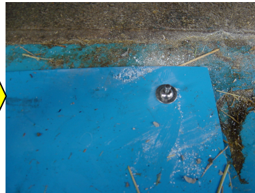
⑧アンカーボルトの頭を確認します。
