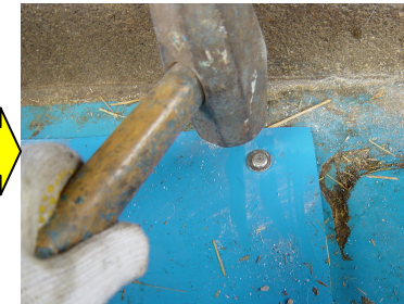
⑨狙いを定めて、ハンマーで、叩き込みます。
