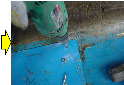
⑥コンクリートドリルで、穴に被らないような場所に、穴をあけます。
