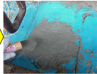
モルタルで、穴を埋めます。
