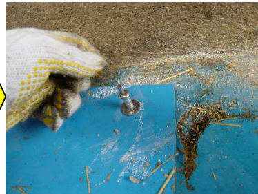
ワッシャをかまして、アンカーボルトを差し込みます。
