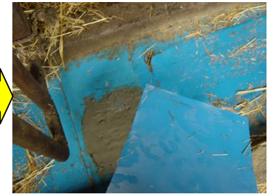
FRP補修板を、置きます。
