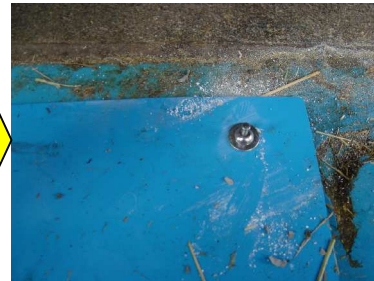
アンカーボルトの頭を確認します。
