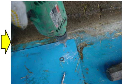
コンクリートドリルで、穴に被らないような場所に、穴をあけます。
